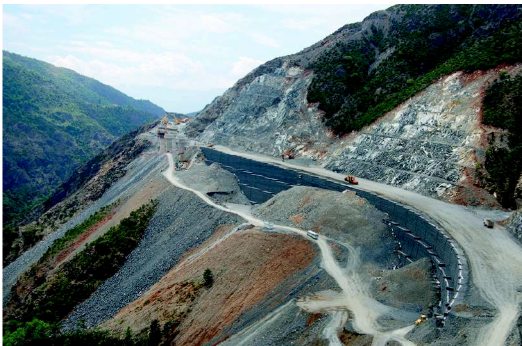
Figura 31 – Recomposição de taludes
