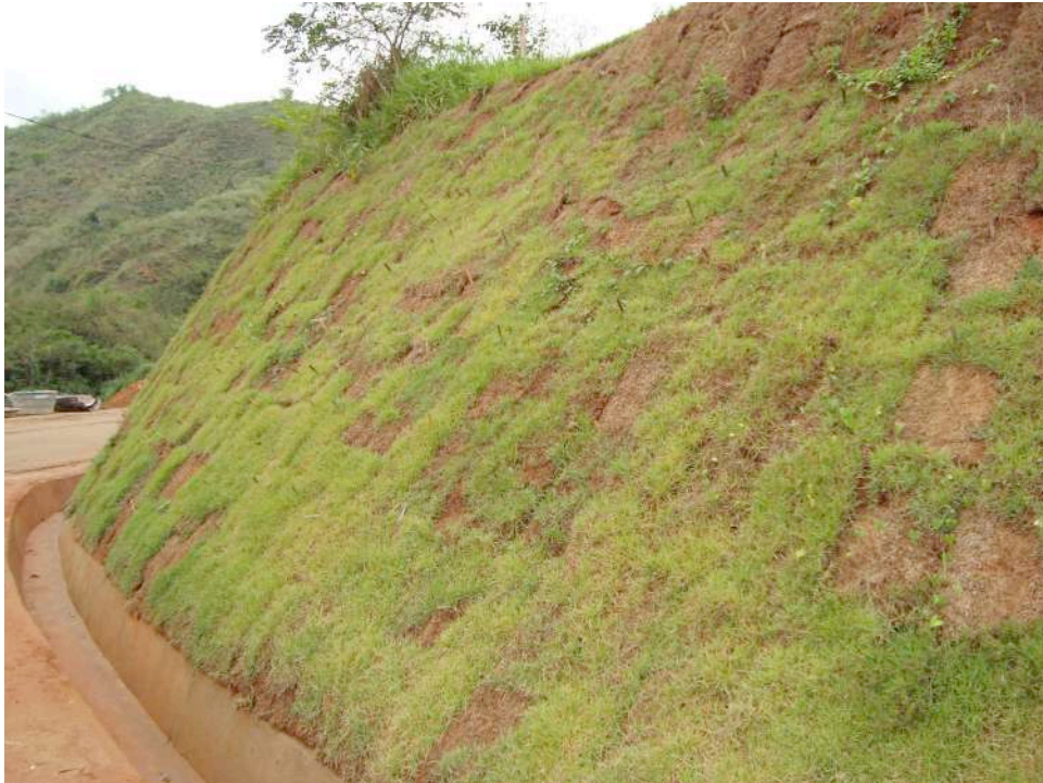
Figura 30 – Cobertura de grama sobre talude no canteiro de obras da PCH São Sebastião do Alto, município de São Sebastião do Alto, RJ.
