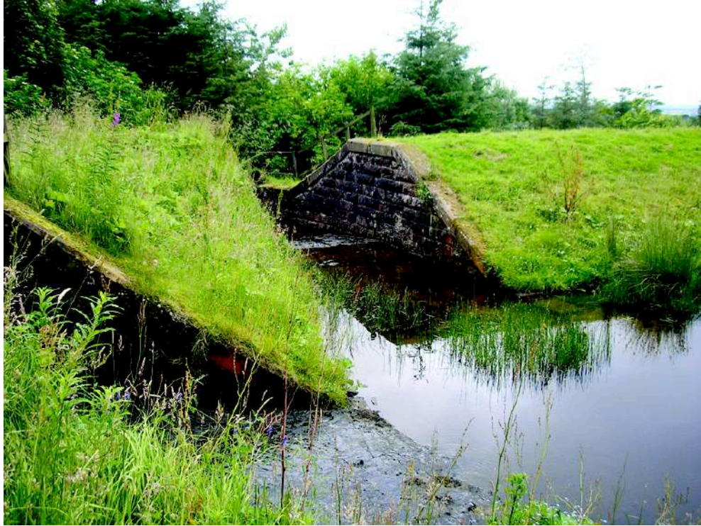
Figura 32 – Dique de terra
